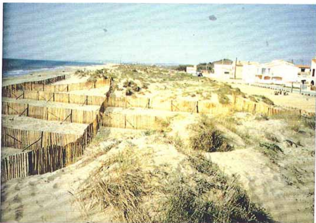
Photo 1 : Ouvrages en ganivelles sur les dunes à Portiragnes, septembre 1986
