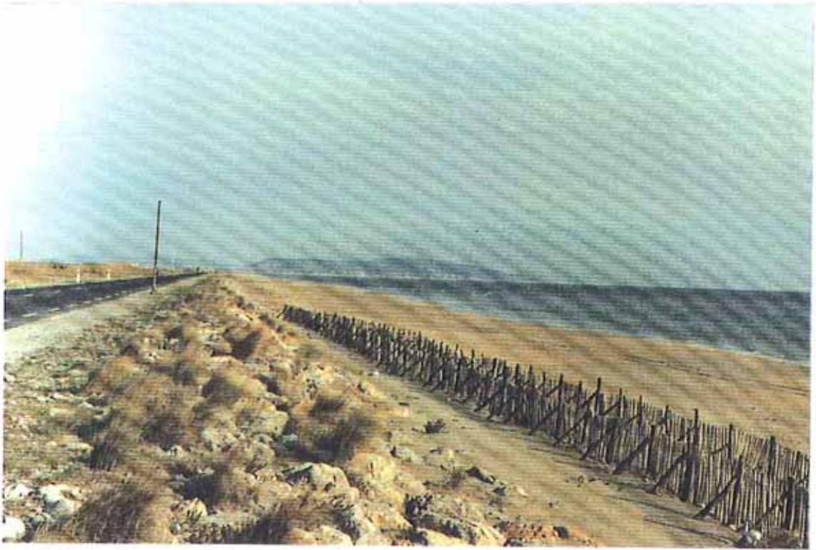
Photo 7 : Ganivelles à la base du talus de la R.N. 112 (La tour de Castellás)
