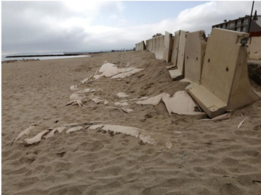
*Illustration 33 – Impact sur la structure de protection ©WaveBumper lors de la tempête de Février 2021.*
