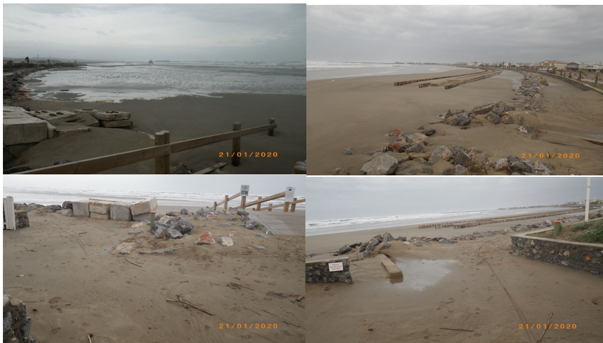
Illustration 49 - Observation de l'inondation de la plage et de l'ensablement de la promenade à Gruissan (Les Chalets) pendant la tempête Gloria en Janvier 2020.
