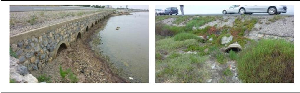
*Figure 27 : Buses d'évacuation sous la RN.*
