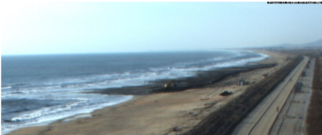
Illustration 4 – Opération de rechargement de plage face à l'atténuateur de houle, image de la caméra 6 le 15/01/2015.;
