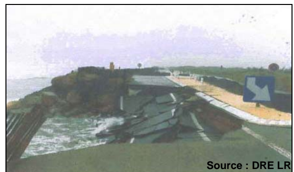
Illustration 9 : Destruction totale de la Digue de Cerbère après la tempête de décembre 2008 (à gauche) et destruction de la RN 112 de Sète à Marseillan après la tempête de décembre 1997
