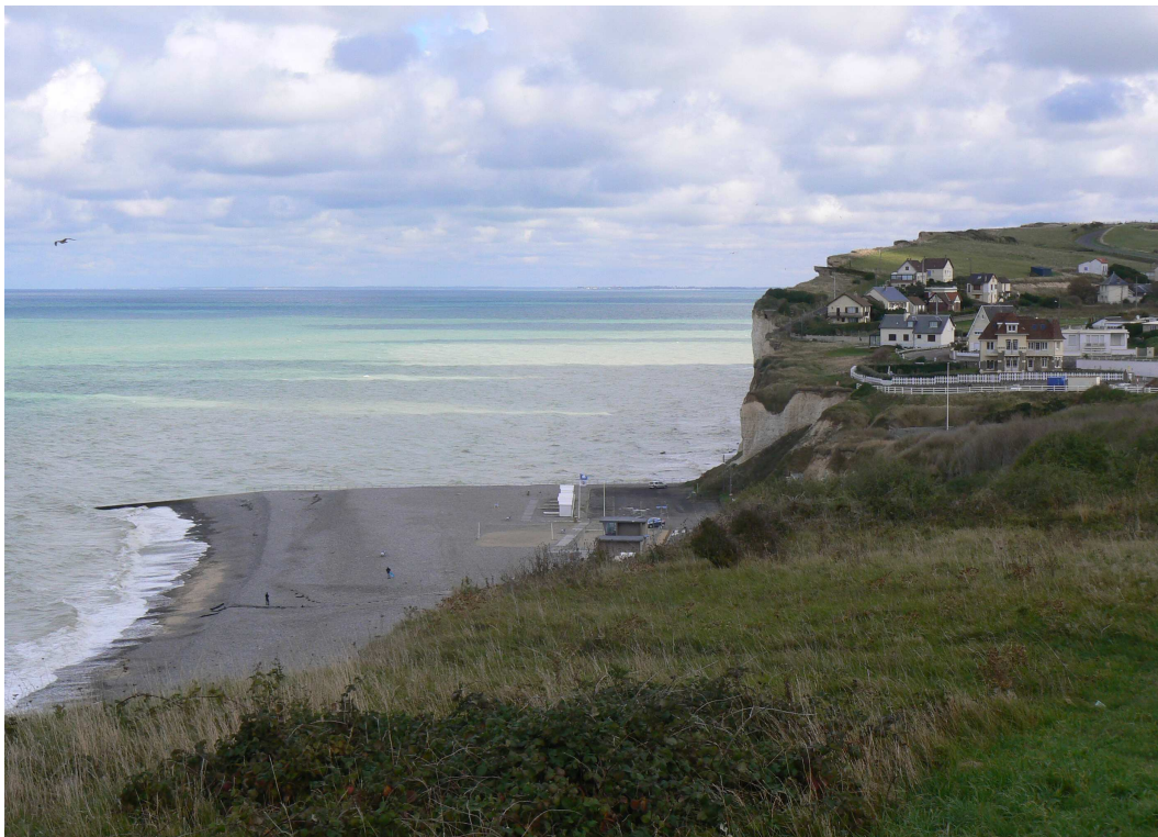
Photo 9 : L'épi de Mesnil-Val interceptant les galets transportés par la dérive littorale dominante
