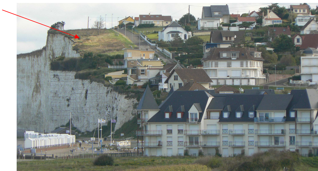
Photo 12 : Photo attestant de l'érosion
