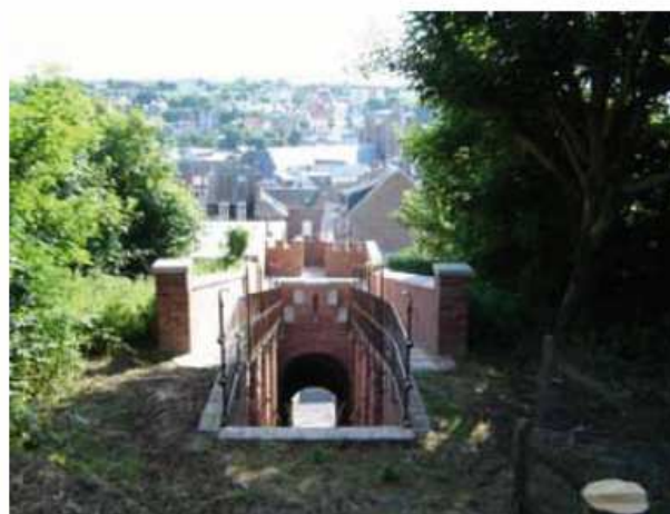
La porte monumentale, côté Moulinet
