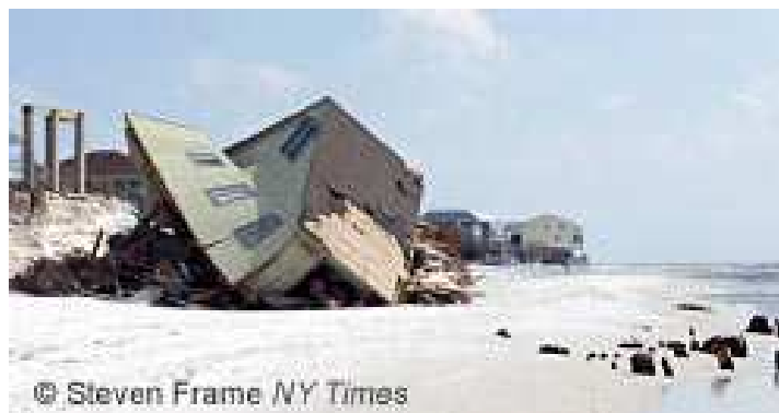
Figure 11 : Erosion au Cap San Blas (Floride)
