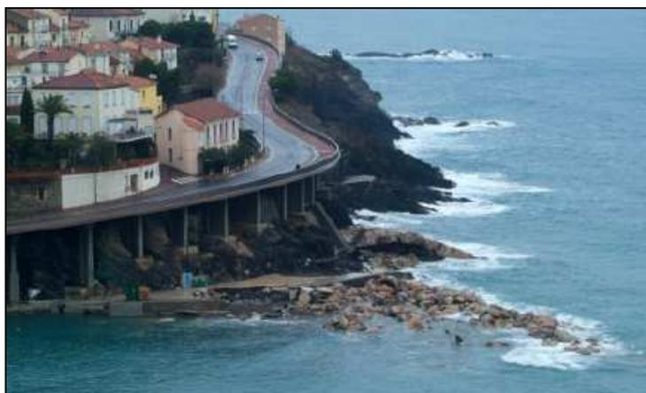
**Figure 1 : Photographie de la destruction de la digue de Cerbère en 2008, (Y. Balouin et al., 2011)**
