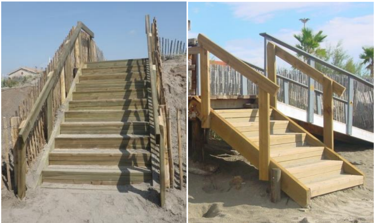
figure 3 : exemples d'escaliers bois (pin traité) de franchissement dunaire, sur sol naturel (à gauche) ou sur pilotis (à droite)
