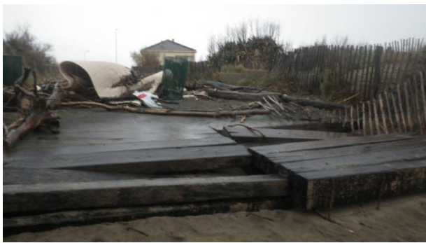
à gauche accès véhicules composite (géotextile structuré sur platelage poutres) ; à droite platelage pilotis (PMR) affouillé
