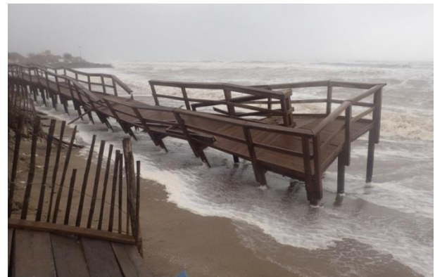
à gauche accès véhicules composite (géotextile structuré sur platelage poutres) ; à droite platelage pilotis (PMR) affouillé
