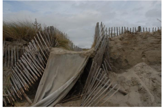
à gauche accès sur sol naturel, déchaussé par un passage trop intense ; à droite accès piéton avec géotextile souple, détruit
