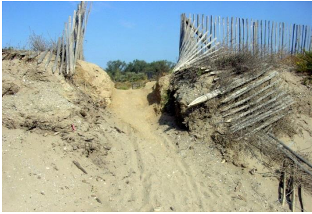
à gauche accès sur sol naturel, déchaussé par un passage trop intense ; à droite accès piéton avec géotextile souple, détruit
