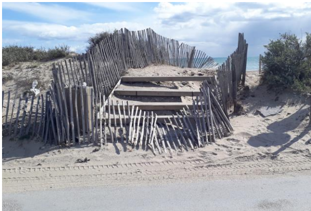
à gauche escalier bois posé, affouillé ; à droite escalier bois sur pilotis tombé sur la plage
