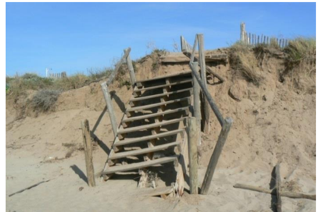
à gauche escalier bois posé, affouillé ; à droite escalier bois sur pilotis tombé sur la plage
